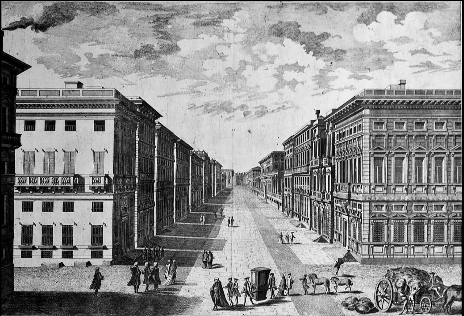
Rue de la Rue nouvelle
